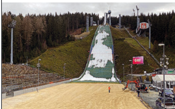
Der Schanzenauslauf der Klingenthaler Vogtland-Arena wird derzeit durch Mitarbeiter der VSTR Rodewisch AG zum Eisstadion umgebaut. 400 Tonnen Sand bilden die Grundlage für die Eisfläche. Foto: Thorald Meisel
